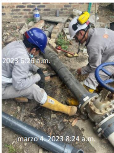
**Fotografía No. 5** Corte de la red de tubería
