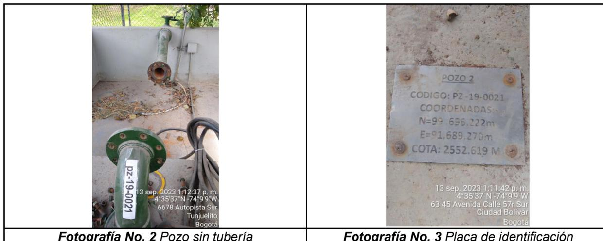
**Fotografía No. 2** Pozo sin tubería
